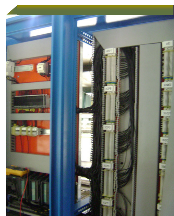
Pruebas durante el armado del tablero CCM4 sector Deschallados.
