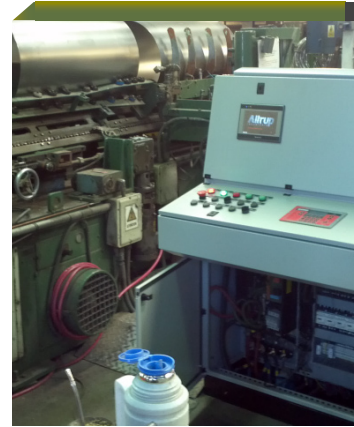
Pruebas de soldadura luego del montaje y cableado del nuevo tablero.
