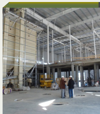
Inicio trabajos en planta de procesado de arroz de Molinos Rio de La Plata.
