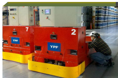
Puesta en marcha de los AGVs. Pruebas de comunicación con el controlador de tráfico.
